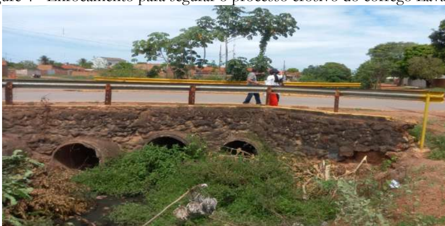
Figure 4 - Enrocamento para segurar o processo erosivo do córrego Lava Pés
